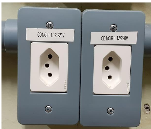
Figura 1 - Exemplo de identificação de tomada.
