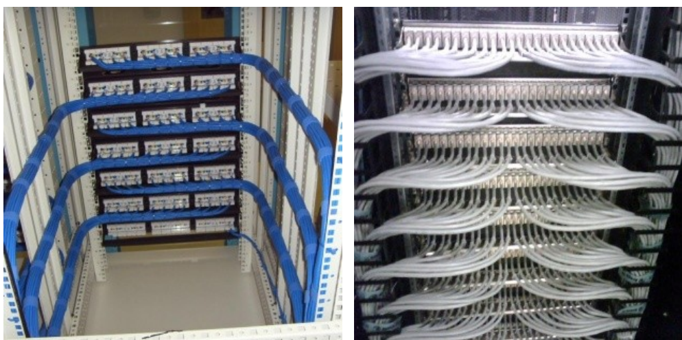
Fig. 2: Detalhe da organização de cabos UTP no rack já conectorizados.
